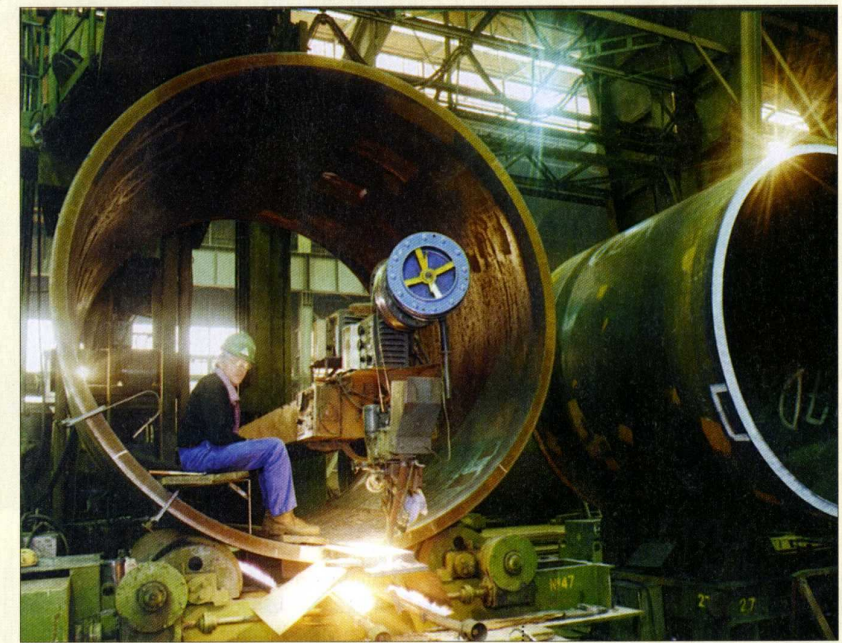
CMP Dunkerque a travaillé sur des chantiers prestigieux comme la réalisation du Tunnel sous la Manche. © MG productions
